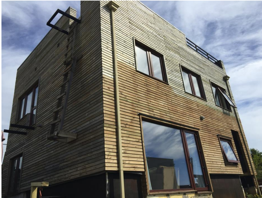
Figura 7: Vivienda Terminada. Fuente propia.
