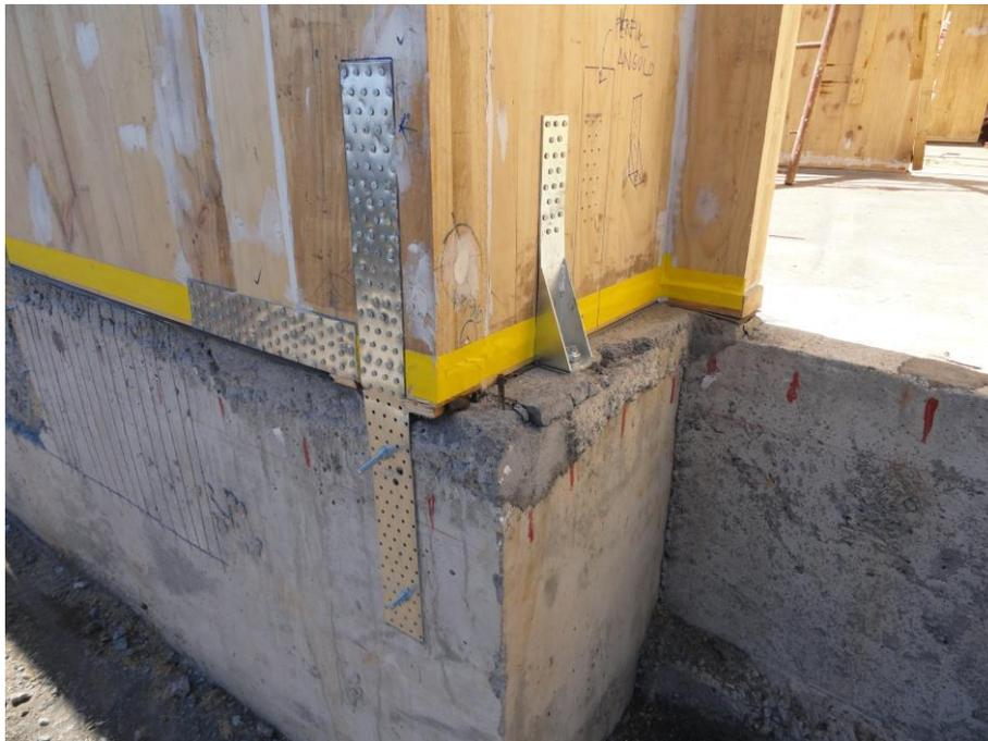
Figura 4: Ángulos Metálicos exteriores. Fuente propia.
