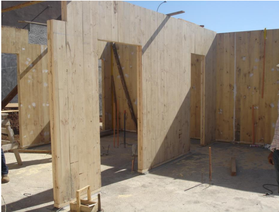
Figura 1: Paneles CLT primer piso. Fuente propia.
