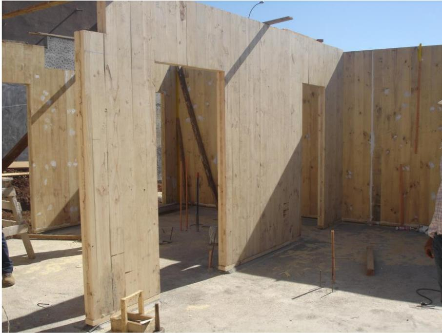
Figura 1: Paneles CLT primer piso. Fuente propia.
