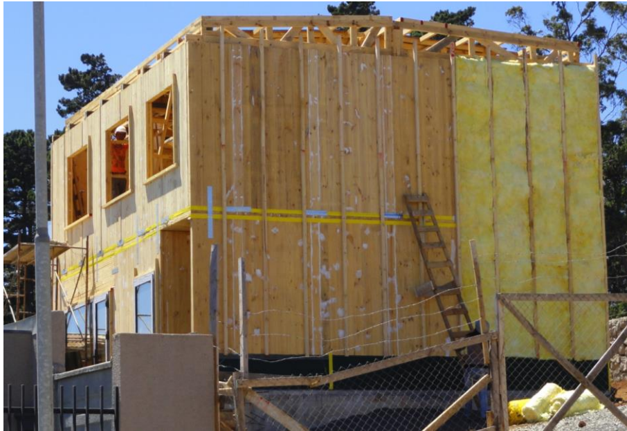
Figura 5: Primera capa de Aislación. Fuente propia.
