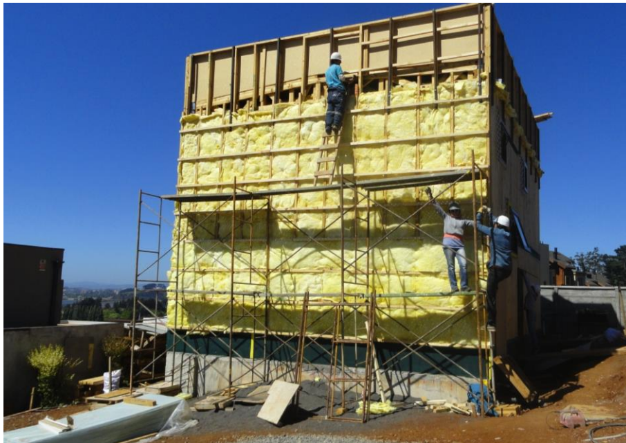
Figura 6: Segunda capa aislación. Fuente propia.
