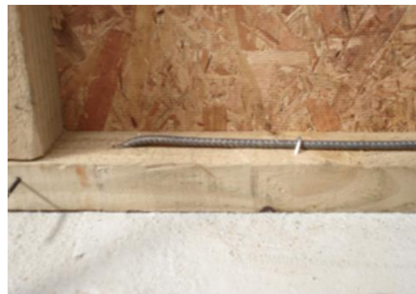
b) Anclaje de barra de acero estriado
