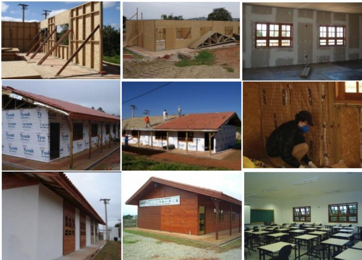
Figura 1: Etapas de la construcción de la sala de madera. Créditos: Guilherme Correa Stamato.
