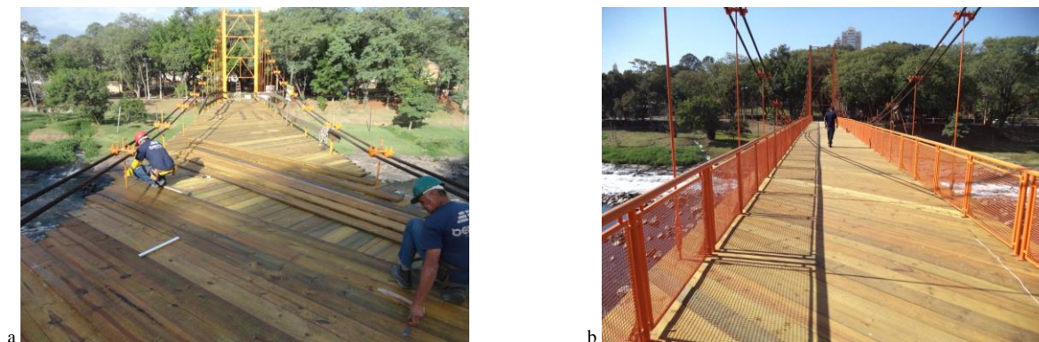
Figura 4.12: Técnicas de reabilitação: substituição de todas às peças Eucalyptus tereticornis biodeterioradas, por peças classificadas de madeira Pinus C30 com espessura de 4 cm em duas camadas totalizando 8 cm de espessura, com sistema cruzado em X. Foto: CALIL JR. (Inspeção detalhada em 26/05/2014)
