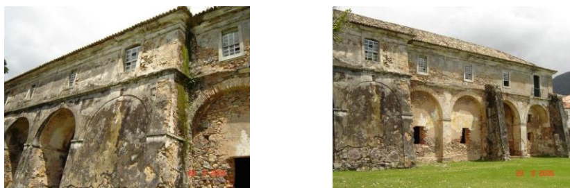
Figura 6: Fachada Nordeste atual, talude no corpo central avançado (esquerda) e contrafortes (direita) (10)
