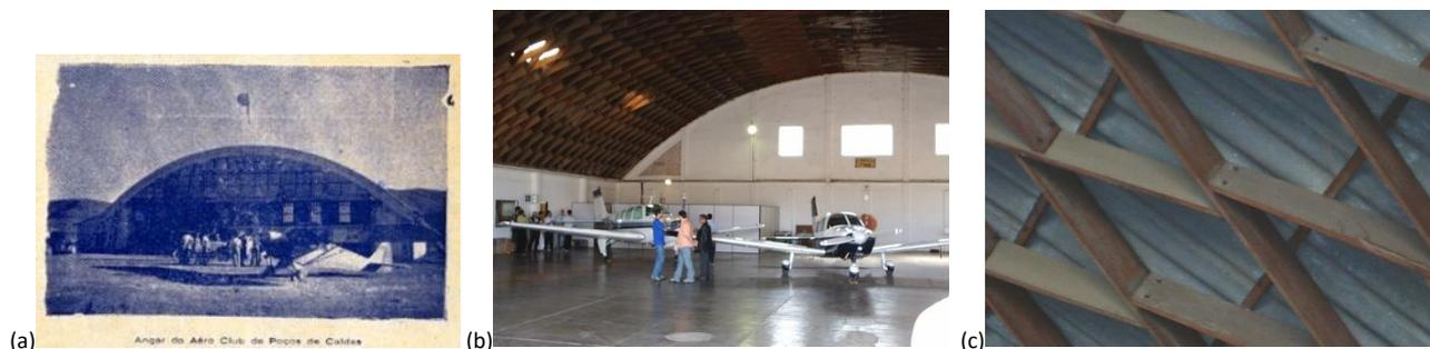
Figura 4.1.1: Cobertura de madeira lamelar semicilíndrica, do hangar do Aero Clube de Poços de Caldas. Fonte: [Aero Clube de Poços de Caldas, 1945]; Fotos recentes: Autores.
