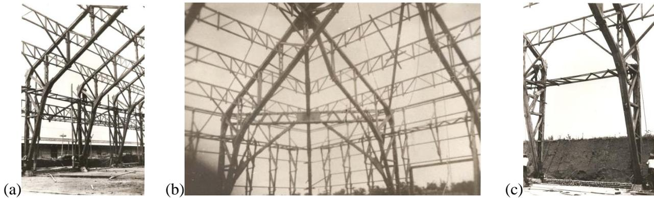
Figura 3.6: Sistemas Estruturais de Pórticos com treliças HAUFF: sistemas de contraventamento composto por terças treliçadas de banços paralelos e mãos francesas (E. Hauff & Cia).
