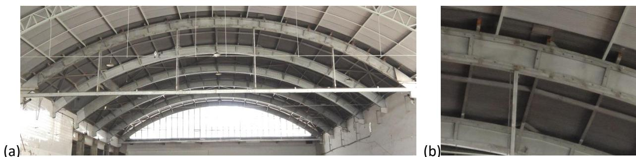
Figura 4.1.4: Cobertura com Arcos de seção I, compostos por madeiras serradas com alma de compensado travado com enrijecedores de madeira, apoiados em consolos de concreto. Foto: Autores
