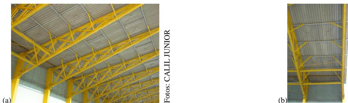
Figura 4.2.3: Cobertura com treliças em balanço (estádio de futebol): falhas no sistema de contraventamento. Fonte: CALIL (2011)
