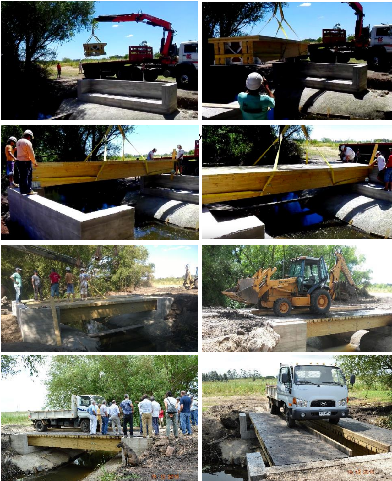
Figura 9: Colocación del puente y prueba de carga
