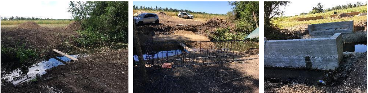
Figura 6: Movimiento de tierras y construcción de estribos de hormigón armado
