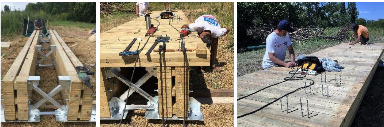
Figura 8: Arriostramiento metálico y unión de paneles CLT y vigas MLE
