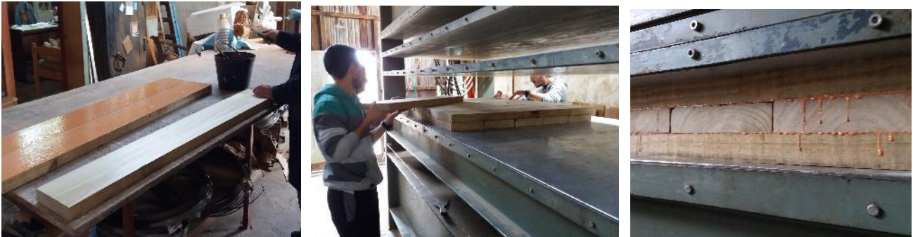
Figura 5: Proceso de fabricación de los paneles CLT
