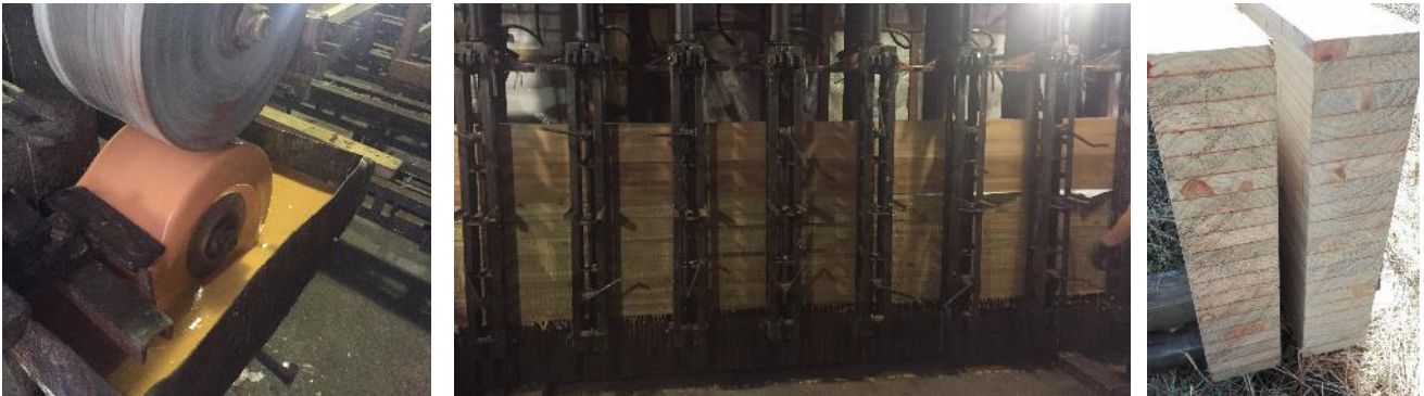
Figura 4: Encolado de lámina, prensado y vigas finalizadas
