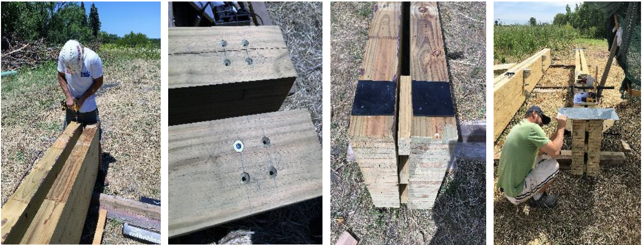
Figura 7: Tornillos de refuerzo de resistencia perpendicular a la fibra y herrajes de apoyo
