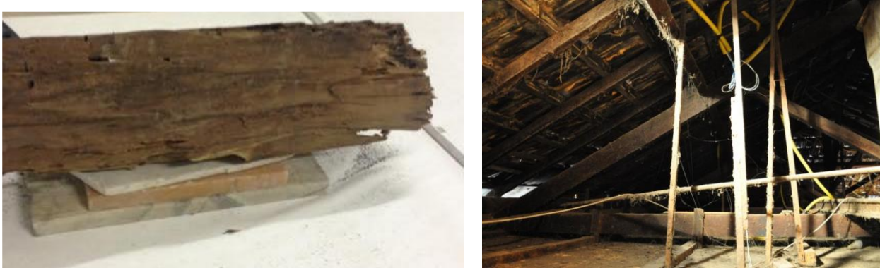
Figura 4: Amostra de madeira e telhado antigo.
