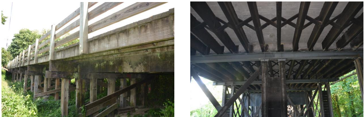
Figura 1. Pontes construídas na década de 30 nos EUA
