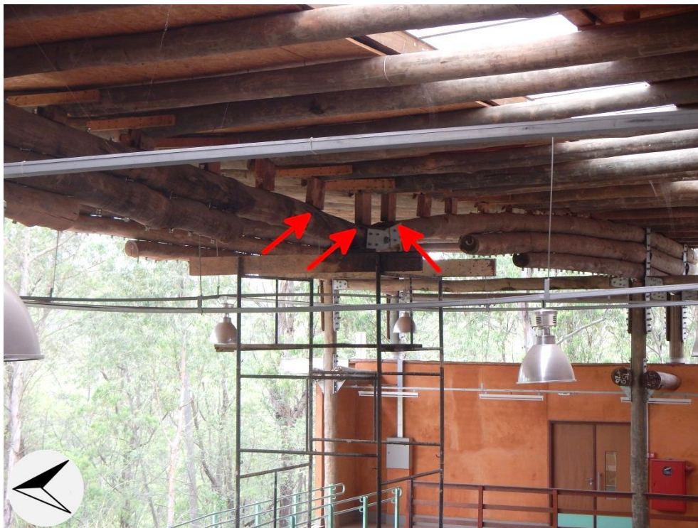
Foto 1: Vista das vigas compostas do Pórtico 1 apoiadas no andaime. As setas indicam os calços sob as terças que sustentam a cobertura do telhado.
