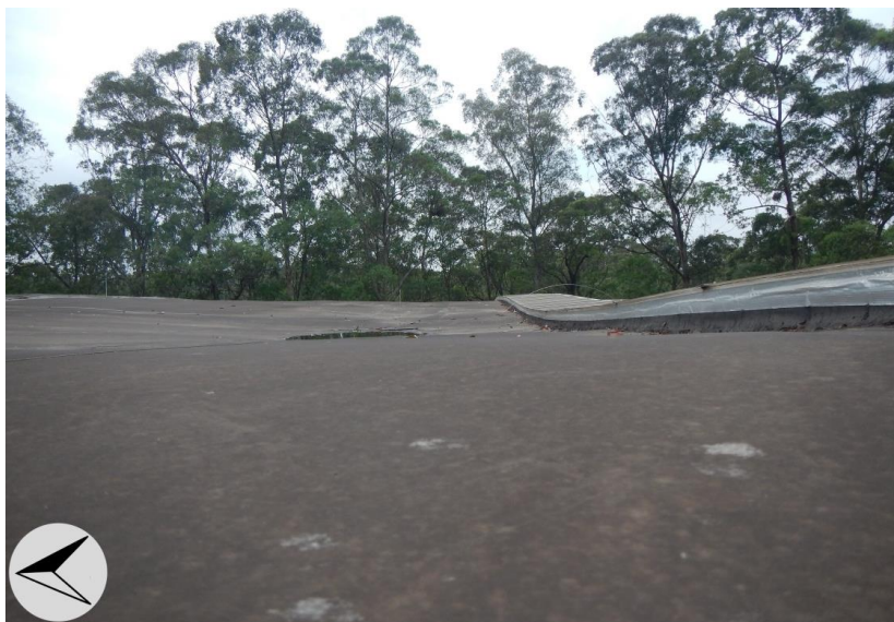
Foto 4: Depressão na cobertura do telhado causada pela deformação do Pórtico 2.
