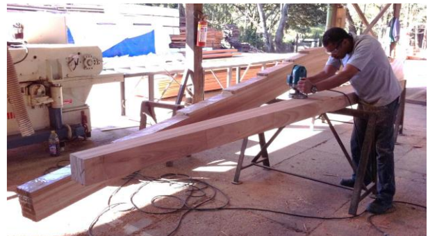
(e) Fabricação das peças de MLC - usinagem manual
