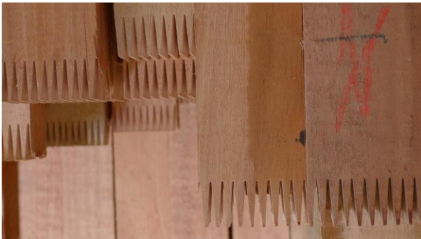
(c) Execução e colagem das emendas do tipo finger joint
